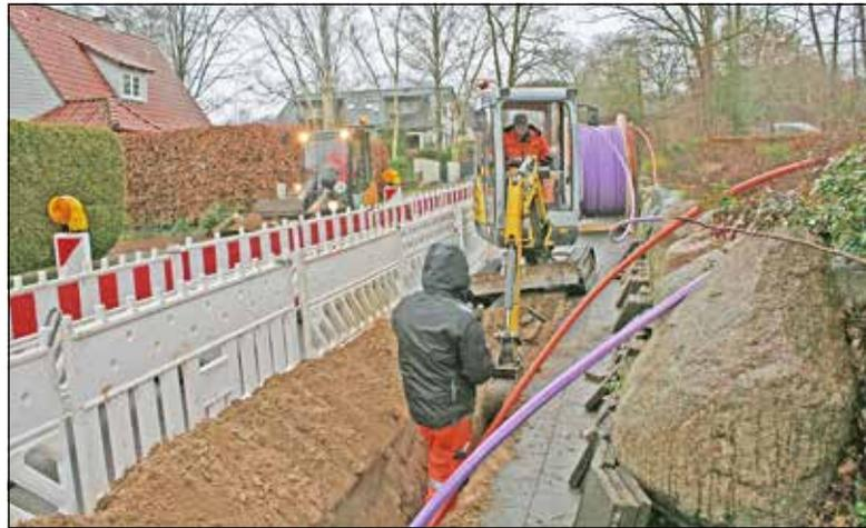
**Das Regenwetter kann die Bauarbeiten nicht aufhalten: Auch in Malente Süd werden zurzeit die Kabel für die bevorstehende Breitbandversorgung verlegt.**
