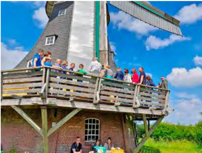
**Die umlaufende Galerie diente als eine Art Arbeitsbühne, um größere Mühlen in ihrer Funktion bedienen zu können. Aufgrund der höheren Lage dieses Balkons waren Flügel, Steert und Bremse zur Bedienung erreichbar.**
