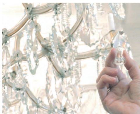
Sanierungsfall: Bei zu viel Erschütterung können sich Teile wie diese Pyramidenspitze aus ihrer (in diesem Fall) Gipshalterung lösen und zerbrechen. Fotos: Jabs
