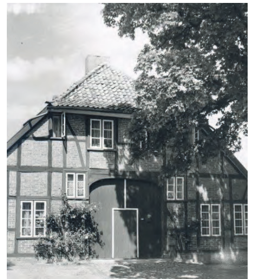
Das Gebäude in der 28 ist ein elementarer Bestandteil des historischen Gesamtensembles in der Weidestraße.
