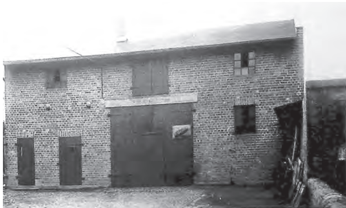
Der Kohlenschuppen vor dem Umbau
