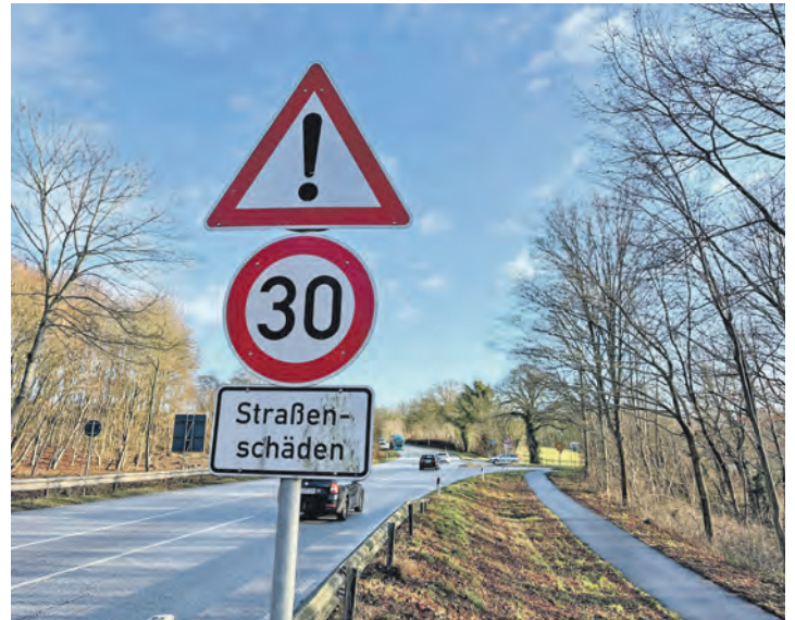
Bis zum Sommer wird es wohl noch dauern, bis das Tempolimit aufgehoben und die Straße repariert wird. Fotos: Graap
