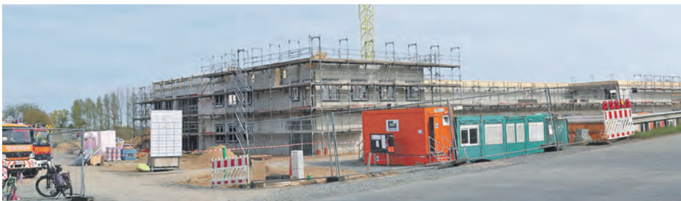
Der Stand der Dinge im April 2026: So sah der Rohbau beim Richtfest aus.
