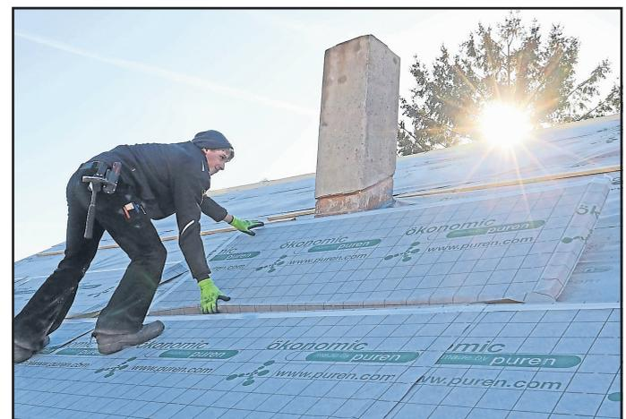
Bei der Dämmung von Dächern spielt der Feuchteschutz eine wichtige Rolle. Vorteilhaft sind Dämmstoffe, die möglichst wenig Wasser aufnehmen können.
