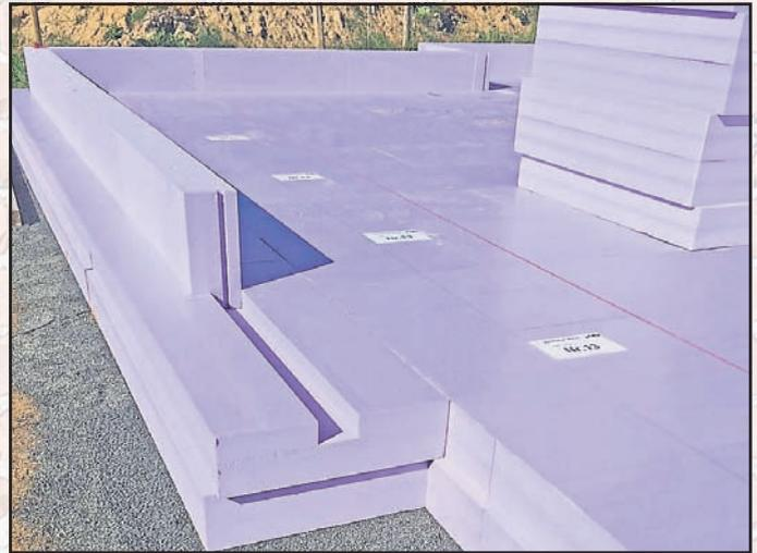
Die Dämmung der Bodenplatte trägt erheblich dazu bei, dass das neue Zuhause von Familie Hartwich den Standard als Passivhaus Plus erfüllt.
