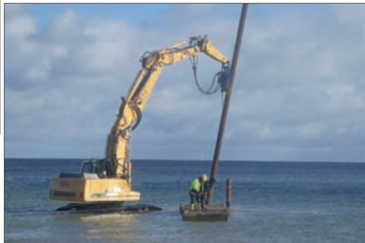
Erste Arbeiten Anfang Oktober.
