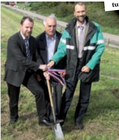
September: Das „Jahrhundert-Bauwerk“ Deichverstärkung wird in Dahme mit dem ersten Spatenstich begonnen.
