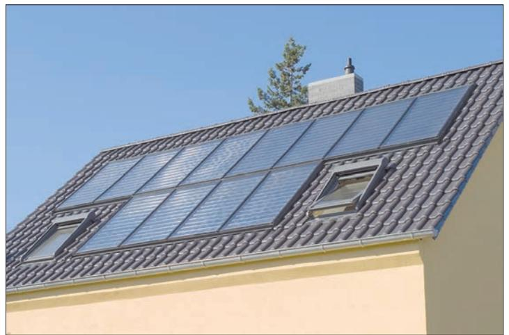
Mit einer Solaranlage muss im Sommer kein Heizöl verbraucht werden. Denn für die Warmwasserversorgung genügt die von den Kollektoren gesammelte Sonnenenergie.
