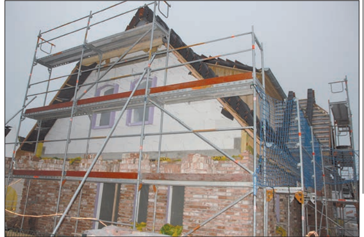
Der Neubau der Backsteinkate entsteht in Grömitz, Möwenstraße 26.
