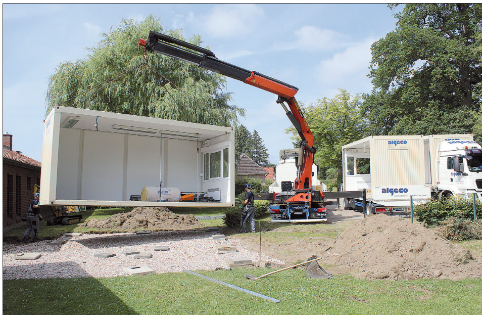
Am Kran schwebten die drei Containermodule Mitte Juli an ihren Platz. Sie bilden zusammen einen Raum von sechs mal sieben Metern für eine vierte Gruppe im Kindergarten.
