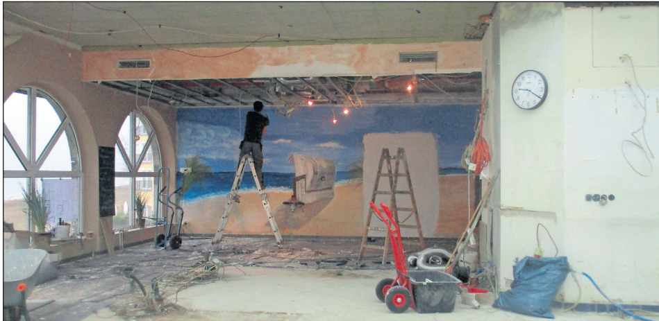
Zum Start im neuen Jahr: Baubeginn für die neue „Meerbar“ in der Ostsee Therme.
