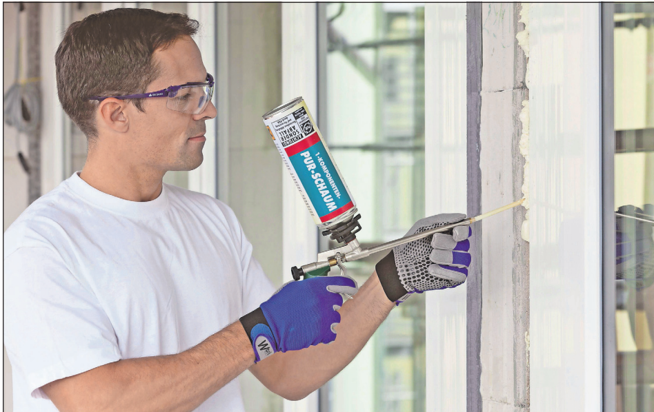
Damit neue Fenster ihre Energiespar-Potenziale voll ausschöpfen, sollten auch die Fensterfugen optimal gedichtet und wärmegeklämt sein. Foto: djd/www.pu-schaum.center
