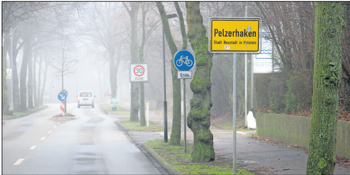
Ortseingang Pelzerhaken: Hinter dem blauen Schild müssen die Radfahrer derzeit auf die Fahrbahn wechseln.
