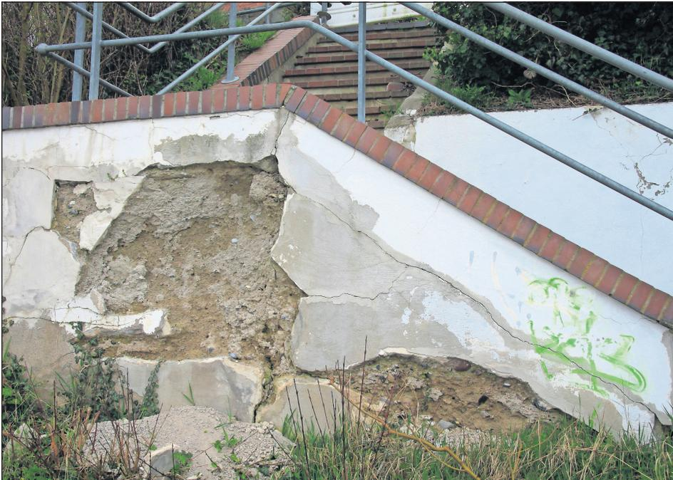
**Trotz der 2005 erneuerten Roll- und Betonschicht ist die seitliche Wange gerissen und ausgebrochen.**
