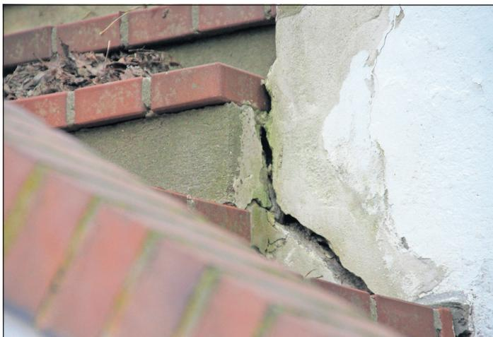
**Auch an den Stufen sind sämtliche Rissfugen zu verzeichnen.**
