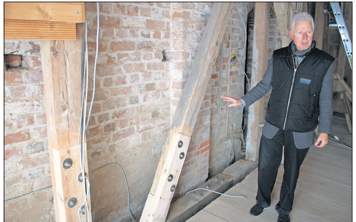
Architekt Torsten Ewers erklärt die aktuellen Baufortschritte.
