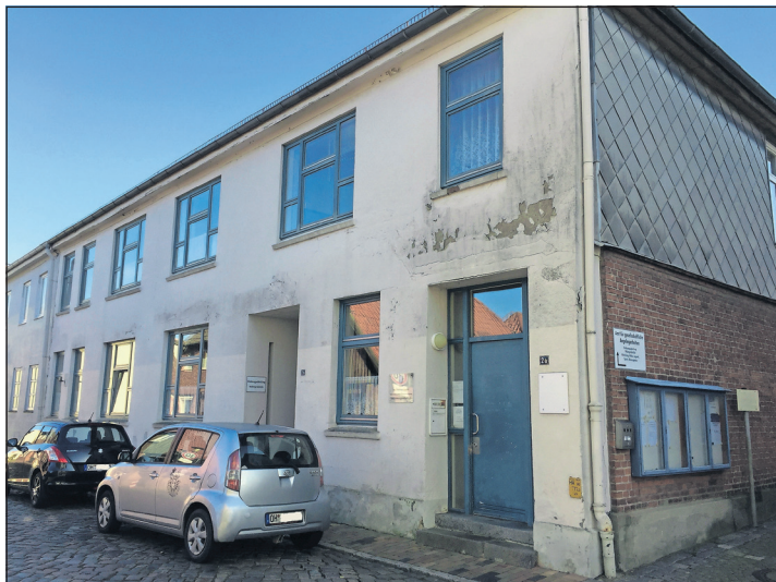
Das alte Gebäude in der Rosenstraße ist marode und kann nicht weiter genutzt werden.
