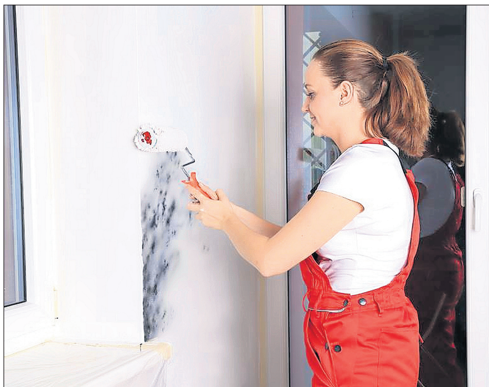
Gegen die unschönen dunklen Flecken an der Wand können Heimwerker mit Anti-Schimmel-Renovierungssystemen selbst vorgehen. Foto: djd/Tikkurila GmbH/PIGROL Farben
