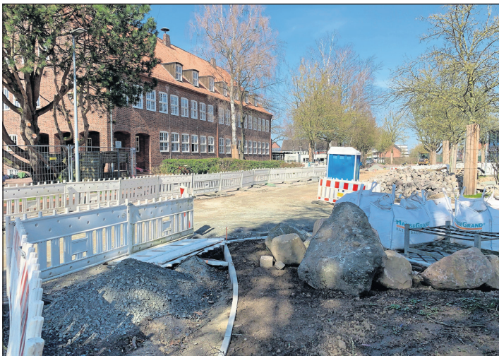
Blick von Norden auf die Baumaßnahmen.
