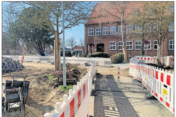
In der „Alten Hochtorschule“ wurde kürzlich mit städtischen Baumaßnahmen begonnen.
