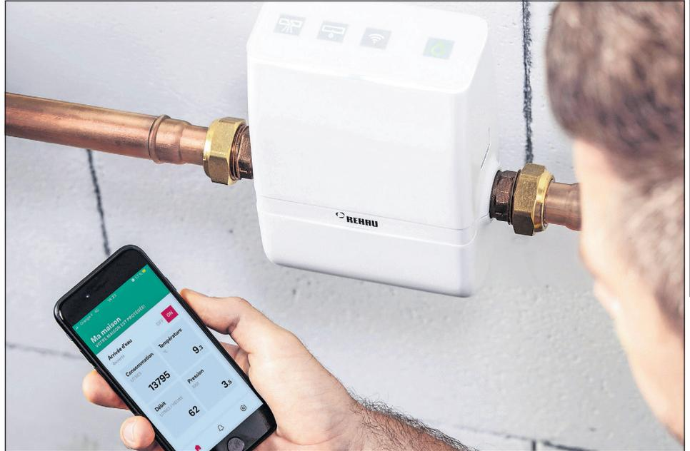
Die smarte Wassersteuerung bedient der Besitzer per App. Foto: djd/REHAU
