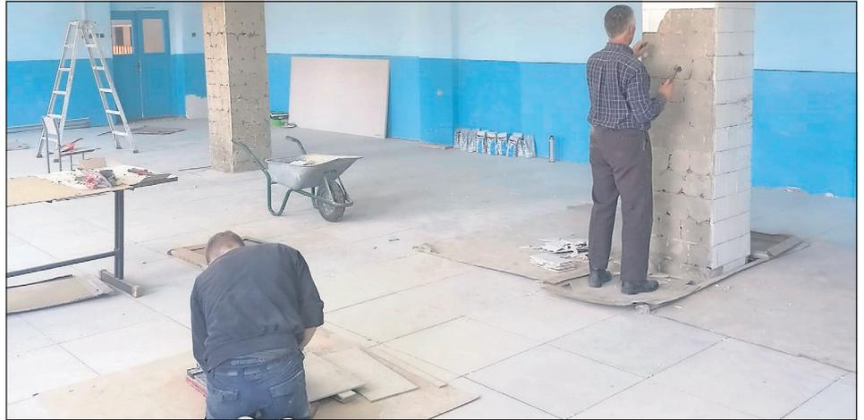
**380 Quadratmeter Fliesen mussten verlegt, die Abwasser- und Frischwasserleitungen erneuert und 22 neue Fenster eingebaut werden.**
