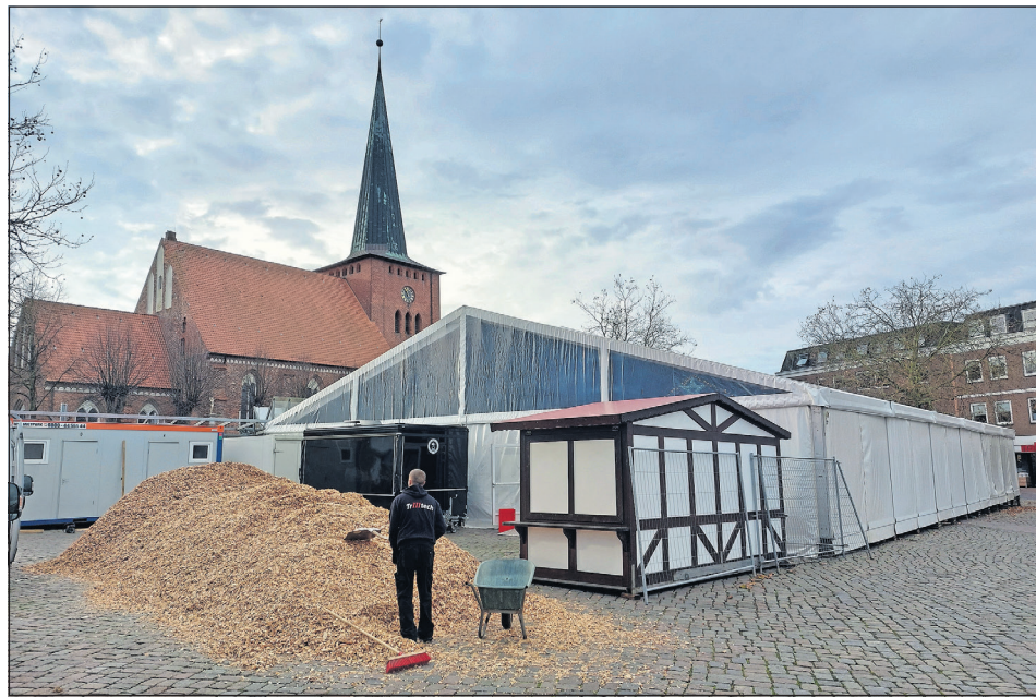
Die Aufbauarbeiten liefen am Montag auf Hochtouren. Holzhackschnitzel wird wieder für warme Füße sorgen.
