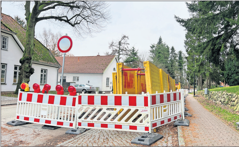
Die Baumaßnahmen im Ortskern bringen nicht nur für die Anwohner Unannehmlichkeiten mit sich.
