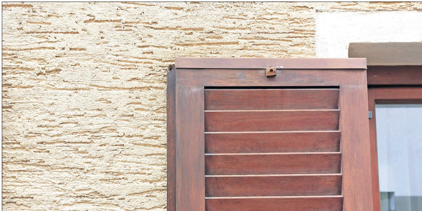
Putzvarianten wie der Besenputz mit horizontalen Linien verleihen Fassaden eine dreidimensionale Wirkung. (Foto: djd/VDPM)
