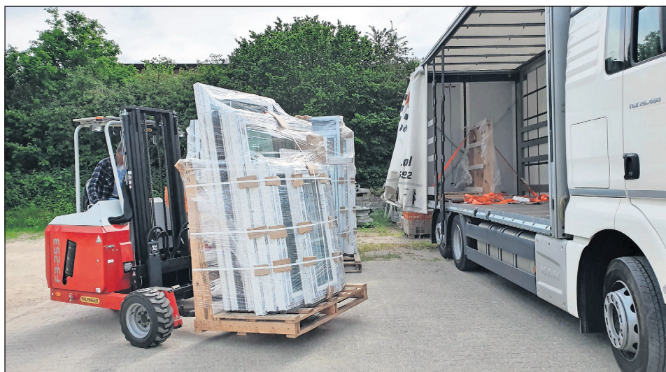
Große Lieferung: Fenster von Avante treffen ein, bereit für den Einbau.
