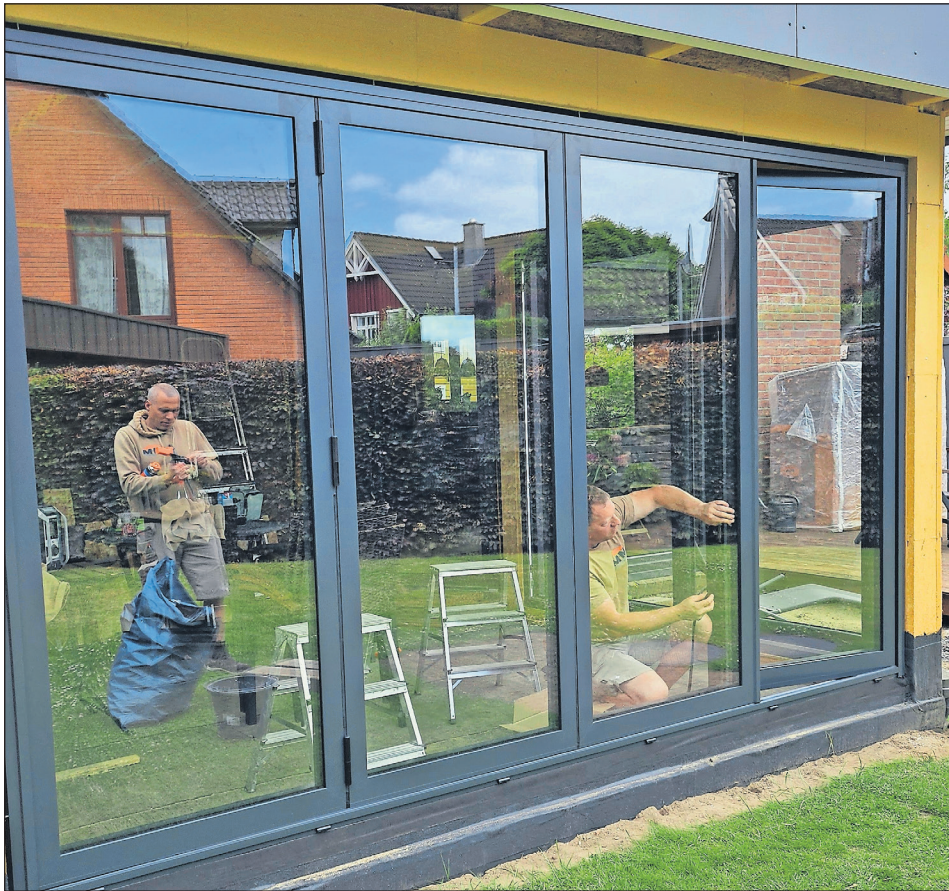
Saubere Arbeit: Das M&M-Team bei der fachgerechten Montage einer Fensterfront.
