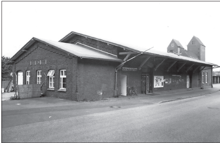
Aus der etwas tristen Güterabfertigungshalle der Deutschen Bahn wurde in viel Eigenleistungen ein „echtes“ Bürgerforum mit vielen Veranstaltungen aus allen Kultursparten.
