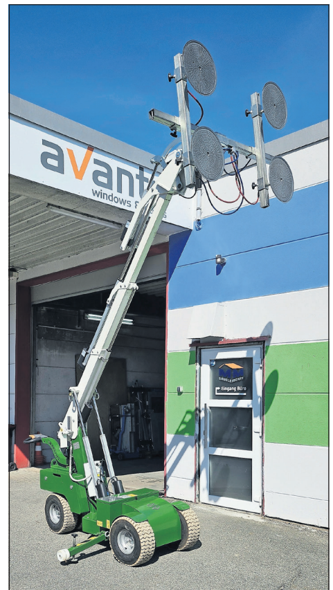
Der Glasroboter hebt schwere Elemente mühelos, auch auf schwierigem Untergrund.
