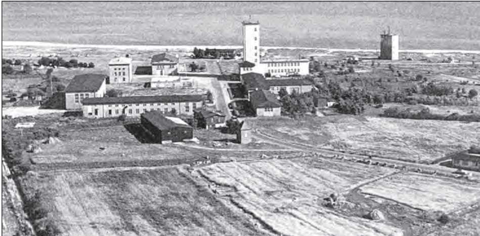
Seit 1992 ist der Horchturm in Pelzerhaken ein Lost Place. (Foto: Günter Bruhse)
