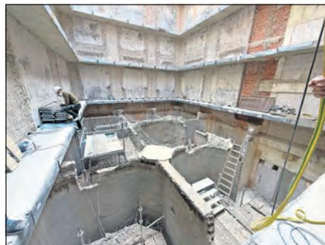
**Schritt für Schritt arbeiten sich die Bauleute durch das Innere des Speichers. Etagenweise werden die Silozellen herausgebrochen und die Betonringe eingesetzt.**
