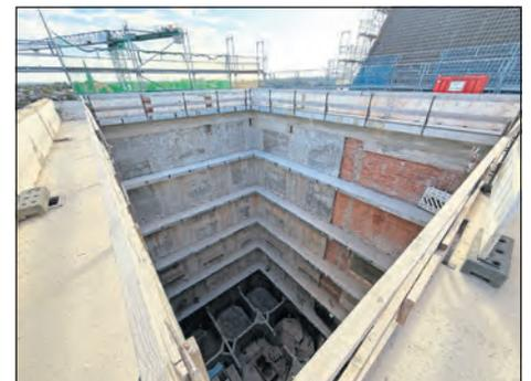
**Blick von oben in den Nordturm: Die massiven Betonringe sollen künftig die Geschossdecken tragen.**
