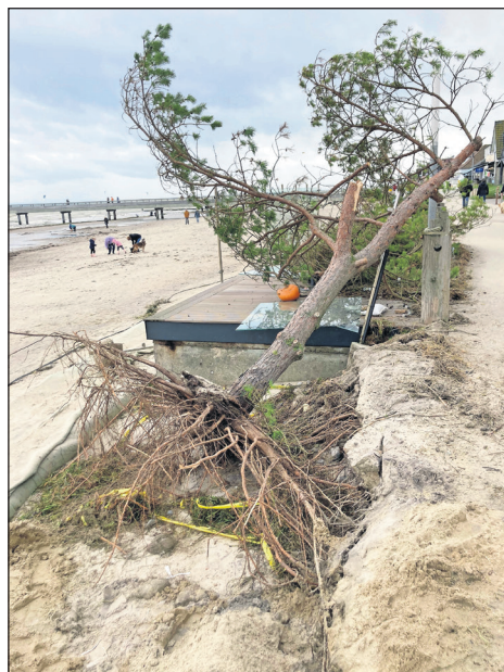
Einen solchen Anblick wünscht sich Kellenhusen nicht zurück: Die Schäden der Sturmflut 2023 sind noch in Erinnerung.
