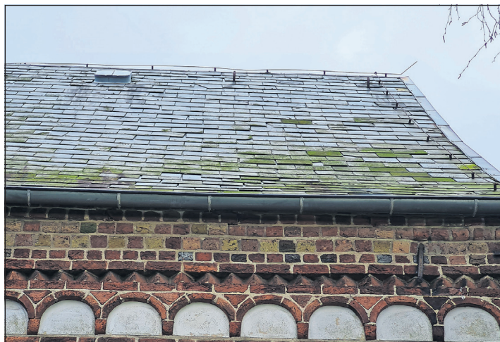
Auch von außen erkennbar: Das Dach vom Chorraum hängt durch. (Foto: Friedemann Holmer)
