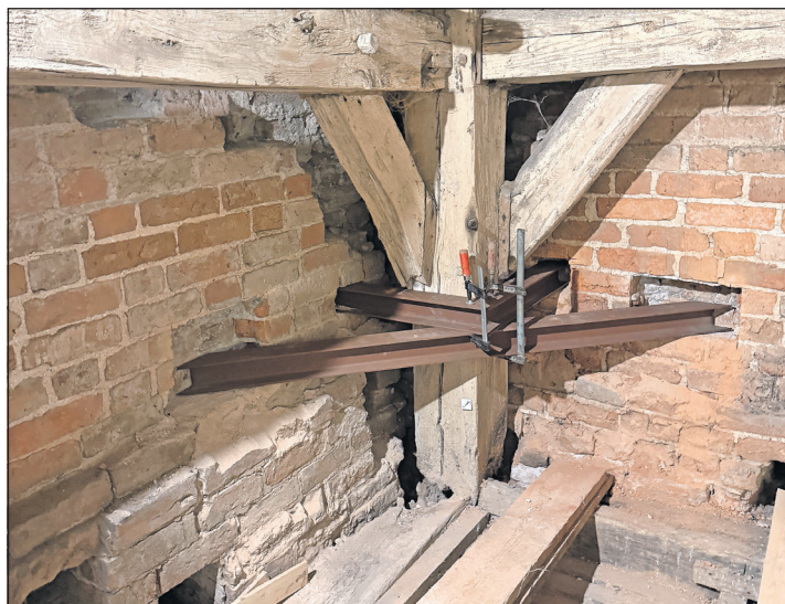
Notsicherungen sollen vorerst die schlimmsten Schäden abfangen.
