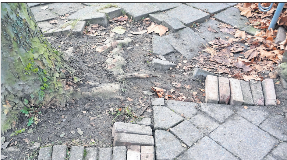
Schäden im Gehwegbereich durch Baumwurzeln.
