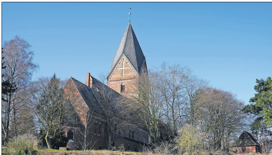
Rund 497.000 Euro vom Bund fließen in die Sanierung der über 800 Jahre alten Basilika in Altenkrempe, damit Schäden am Turm- und Dachtragwerk behoben werden können.
