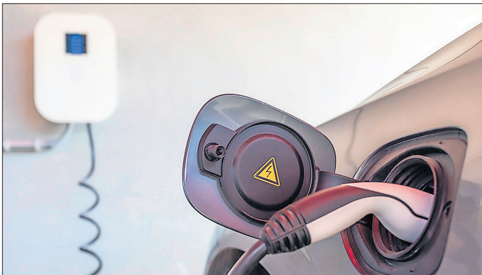
Ein Elektroauto wird an einer Wallbox aufgeladen. (Foto: Adobe Stock / Kara)
