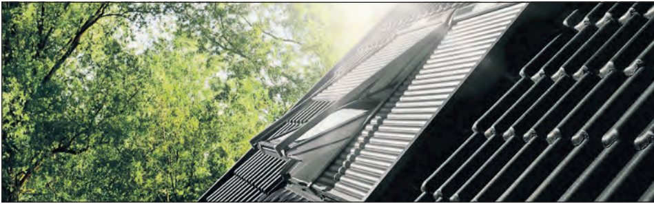
Durch Rollläden ist eine bis zu 7,5 °C reduzierte Raumtemperatur im Sommer möglich. Foto: Velux/akz-o
