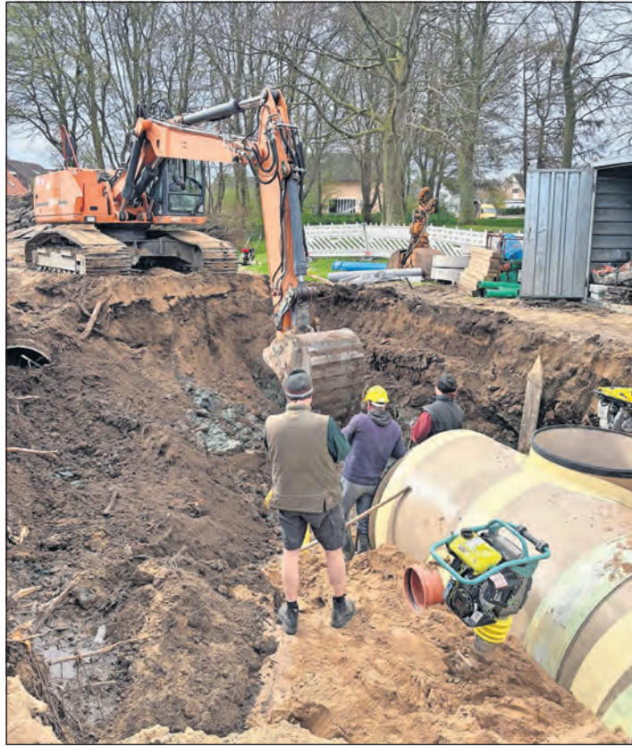
Bauarbeiten am dritten Bauabschnitt in Höhe Gemeindehaus/Geldskapelle.
