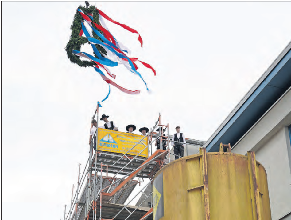
Am vergangenen Freitag wehte die Richtkrone über dem Neubau.
