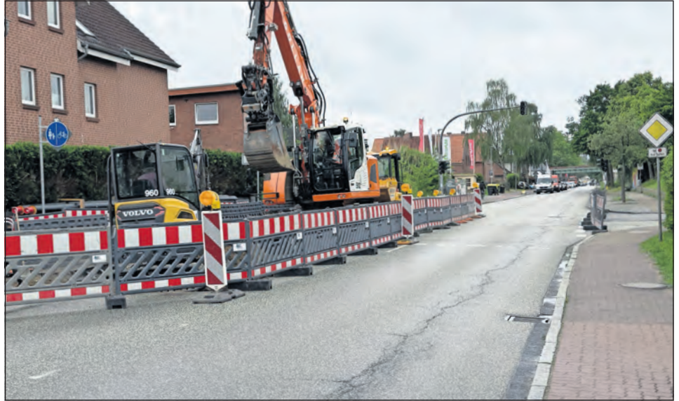
Die Baustelle in der Eutiner Straße ist gestartet.
