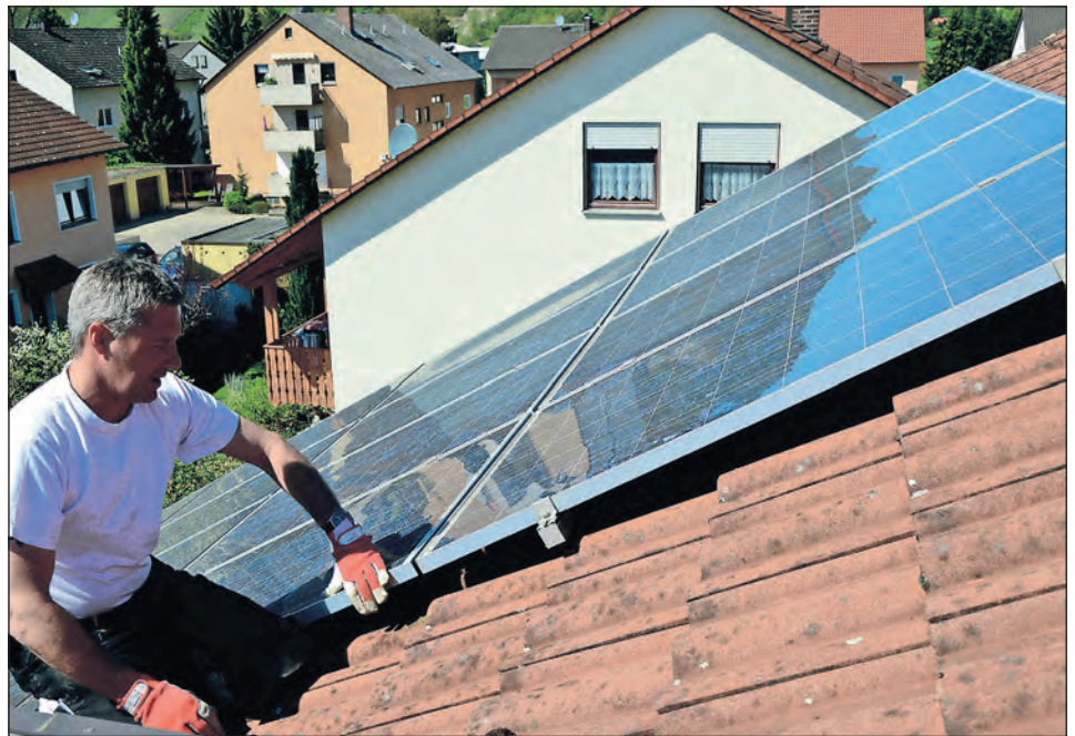
Der qualifizierte Dachdecker prüft die Befestigungen der Solarmodule und begutachtet die Unterkonstruktion im Rahmen des DachChecks. Foto: HF Redaktion/akz-o
