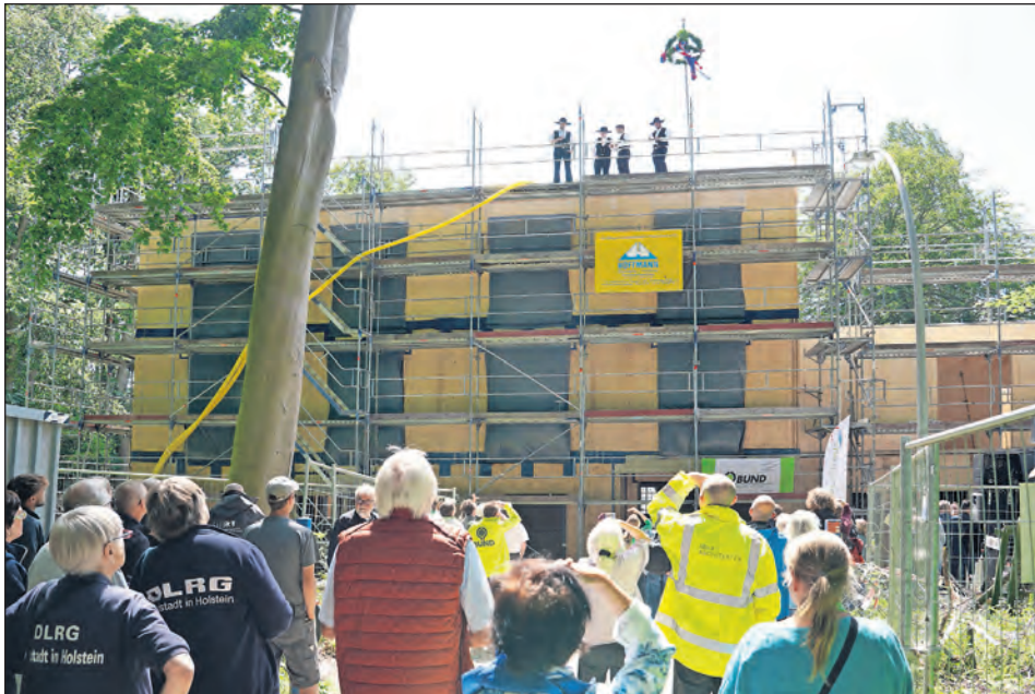
Martin Baumanns von der Zimmerei Hoffmann sprach hoch oben auf dem Bau den Richtspruch.
