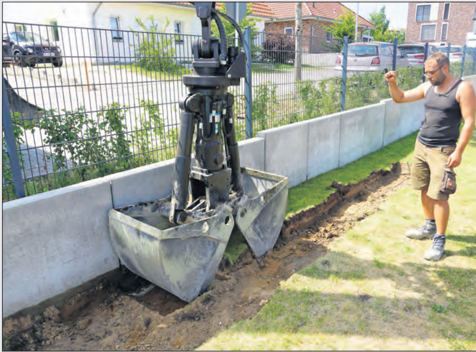
Der Erdaushub wurde von der Firma Gollan übernommen.
