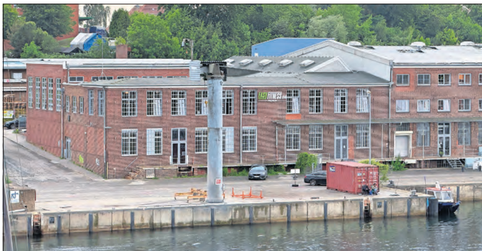
In der ehemaligen „Glückslee“-Fabrik wollte der Verein mit der Unterstützung der Stadt Räumlichkeiten anmieten.
