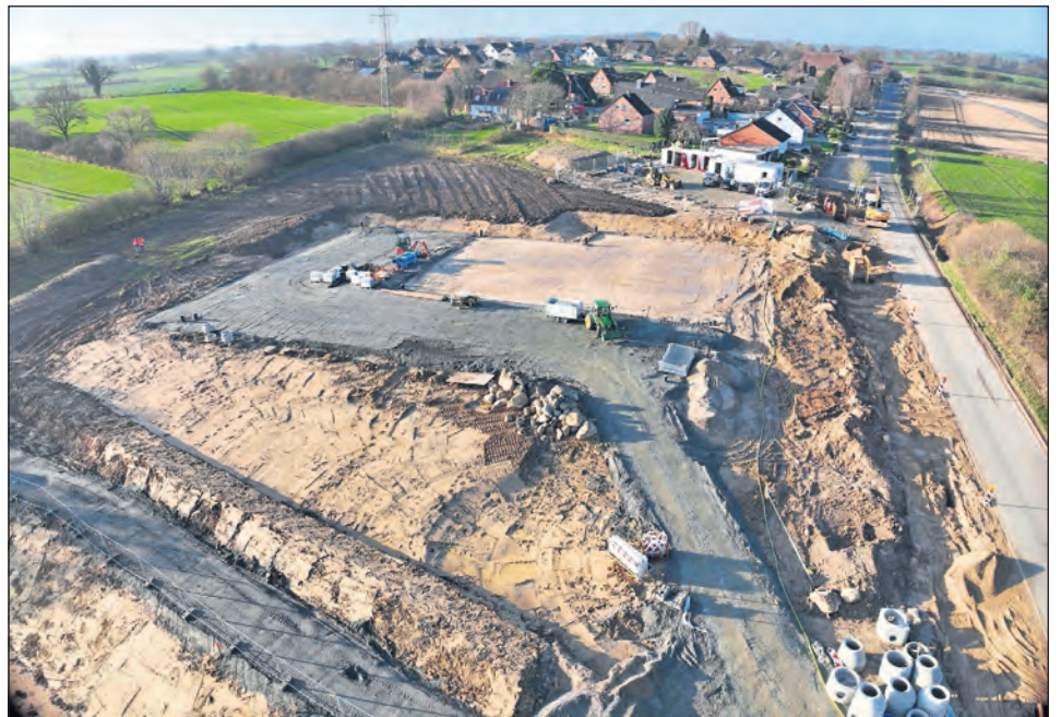
Mit den Erdarbeiten wurde im Oktober 2025 begonnen. (Foto: Architekt Hoffmann)
