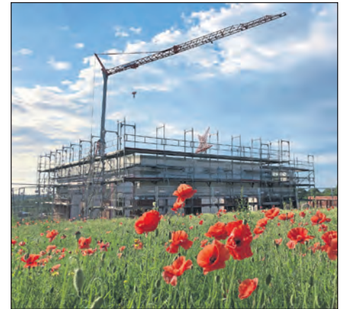
Ein Blütenmeer im Vordergrund, ein Feuerwehrhaus im Bau. (Foto: Architekt Hoffmann)
