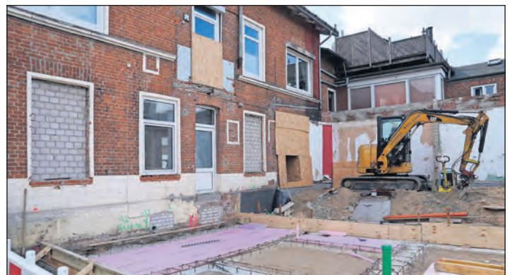
Derzeit laufen die Bauarbeiten, denn die Räume werden vergrößert und saniert, um die Qualität des Angebots nochmal zu steigern.
