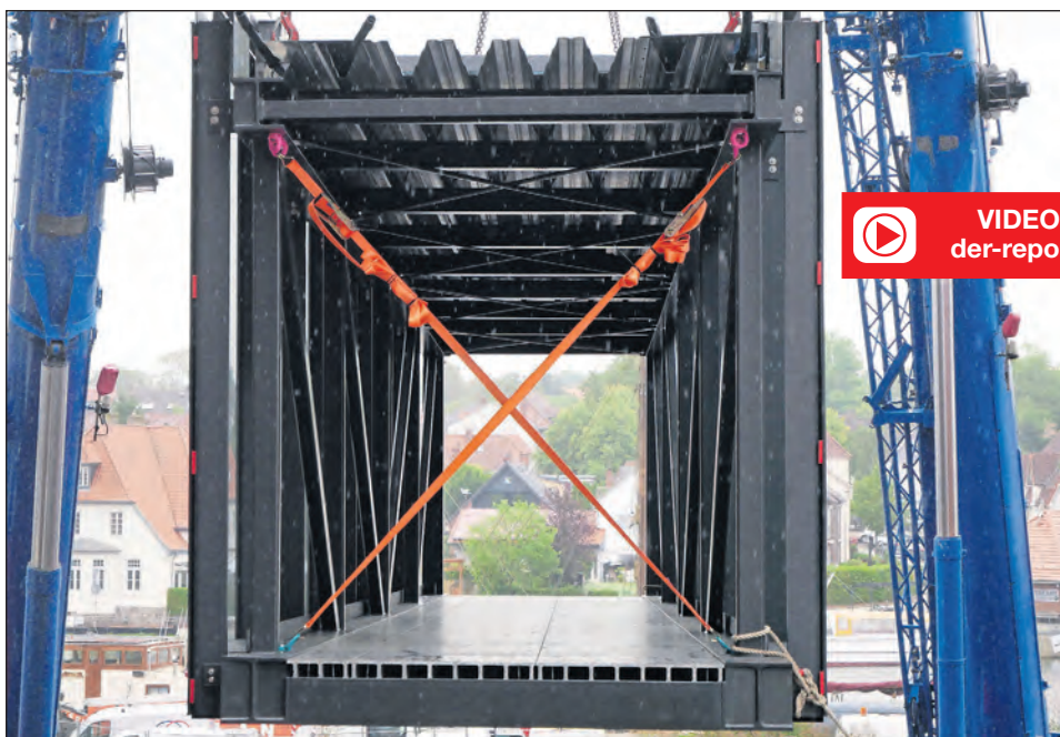
Die Glasbrücke sitzt: Im zweiten Obergeschoss verbindet sie künftig den denkmalgeschützten Getreidespeicher mit dem Neubau.
