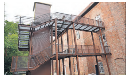
Die sichtbarste Veränderung der Anlage ist der Fahrstuhlurm.
