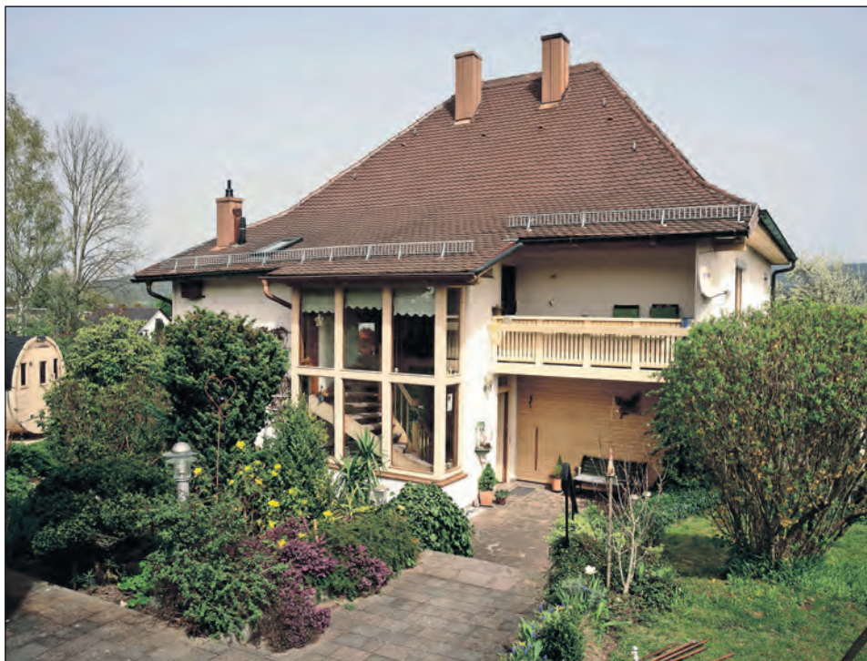
Das rund 100 Jahre alte Zweifamilienhaus in Viechtach wurde im Zuge der Modernisierung bereits auf einen späteren Wärmepumpenbetrieb vorbereitet. Die Kombination aus dem Flächenheizungssystem x-net C16 und den Wärmepumpen-Heizkörpern x-flair verbindet hohen Wohnkomfort mit den Anforderungen moderner Niedertemperatur-Systeme. Foto: Kermi GmbH/akz-o
