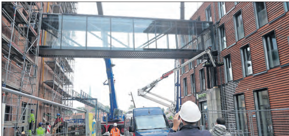
Alt und Neu direkt verbunden: Die neue Glasbrücke bildet den Übergang zwischen dem historischen Speicher und dem aus Holzmodulen errichteten Hotelbereich.
