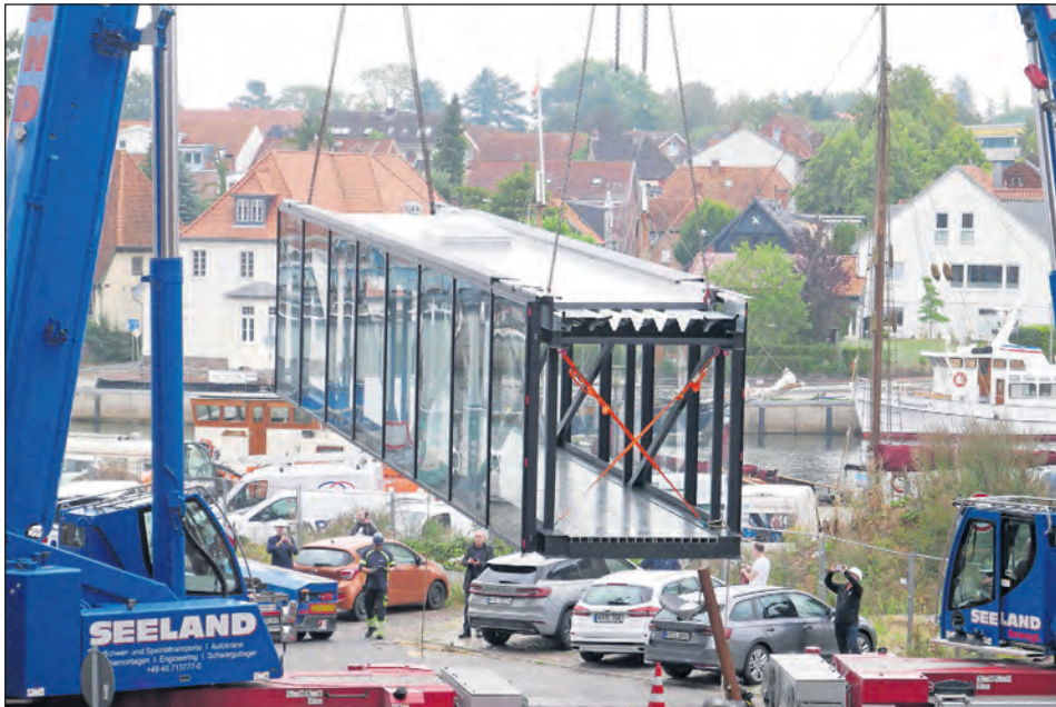
Millimeterarbeit am B&B Hotel: Mit einem Kran wurde die Glasbrücke zwischen dem historischen Getreidespeicher und dem Hotelneubau eingesetzt.
