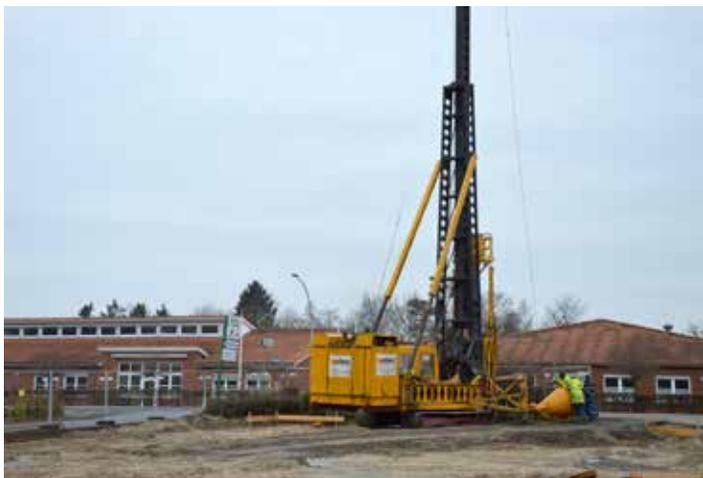
Eine Ramme setzt 24 tief in die Erde gehende Betonpfähle in den Baugrund des neuen TalenteHauses.
