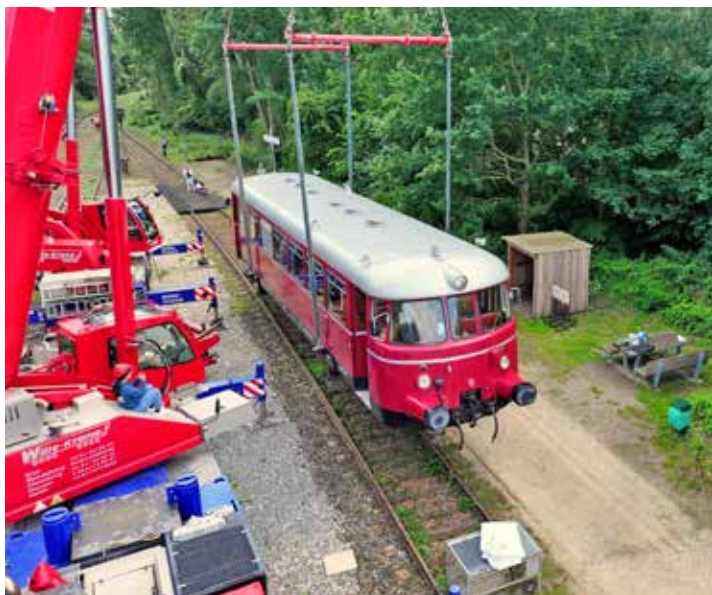
Präzisionsarbeit: Mit Hilfe zweier Kräne wurde der Schienenbus auf die Gleise gesetzt. Foto: „Schienenverkehr Malente-Lütjenburg e.V./ Sylvia & Mathias Pank
