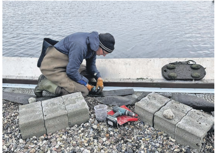
Die Bleche sollen den Ratten den Zugang unmöglich machen.
