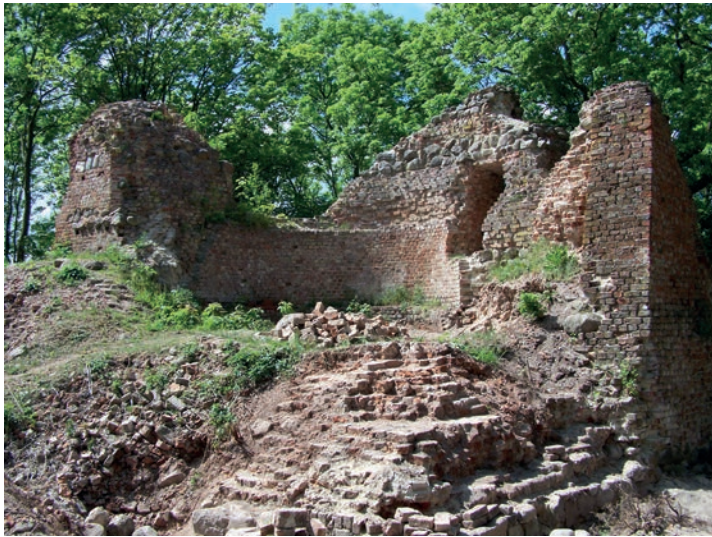
Die Ruine des hoch- und spätmittelalterlichen Turms auf Haus Demmin (Fotos: Felix Biermann)
