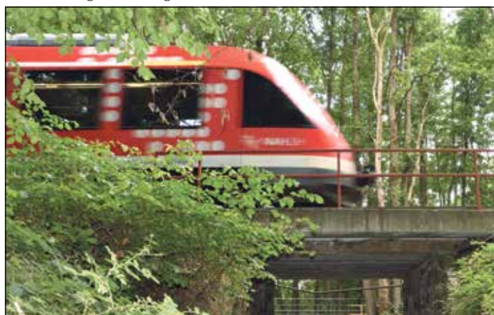
Während der Bauphase pendeln zusätzliche Züge zwischen Preetz und Kiel. Foto: Schneider
