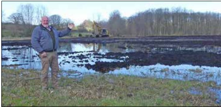
Ernst Bojen hat im moorigen Gelände mit dem Bagger die notwendigen Pflegearbeiten durch Rodung der Büsche durchgeführt.
