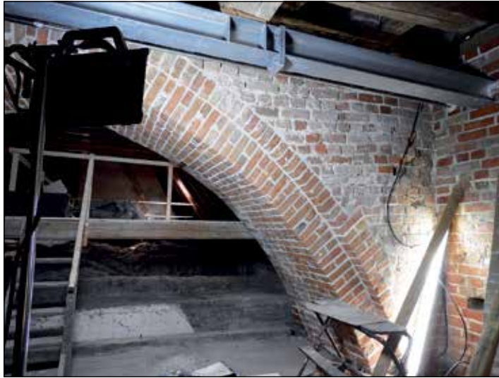
Wieder tragfähig und mit Verstärkung durch einen Stahlträger: der Mauerbogen im Turm ist wiederhergestellt.
