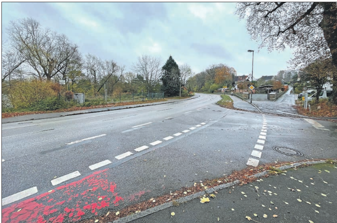
In Sandkaten, Gemeinde Bösdorf, lässt der ZVO im Januar 2023 an der B 76 ein Abwasser Pumpwerk erneuern.
